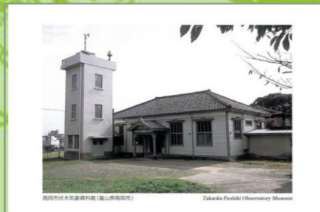
7 高岡市伏木気象資料館
